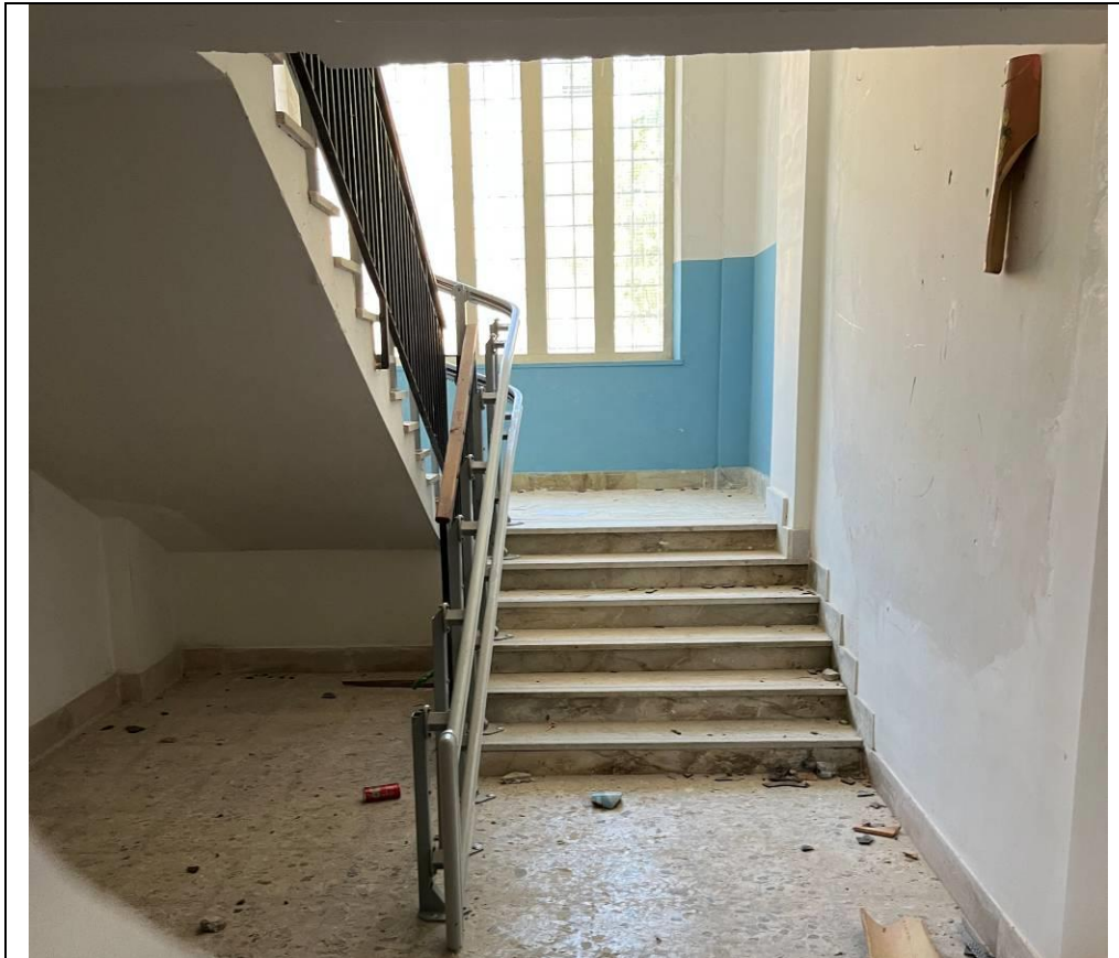
Foto 12 - Vano scala per il piano rialzato.
