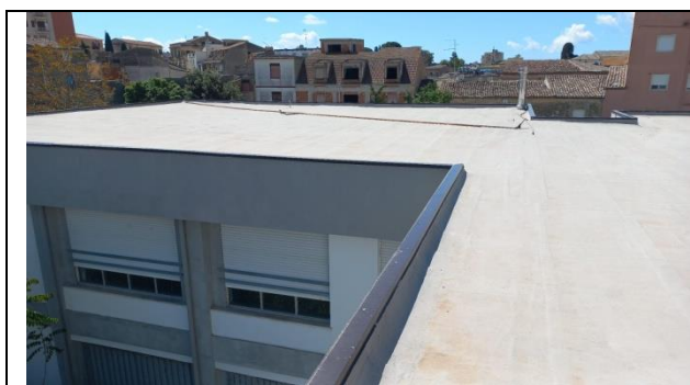
Foto 27 - Panoramica sistema di copertura Corpo C
