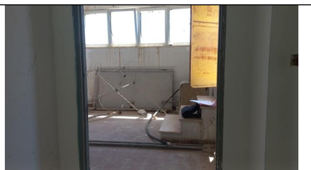
Foto 28 - Torrino di arrivo vano scala I2
