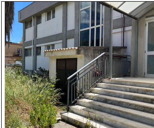
Foto 14a - Panoramica del vano centrale idrica antincendio
