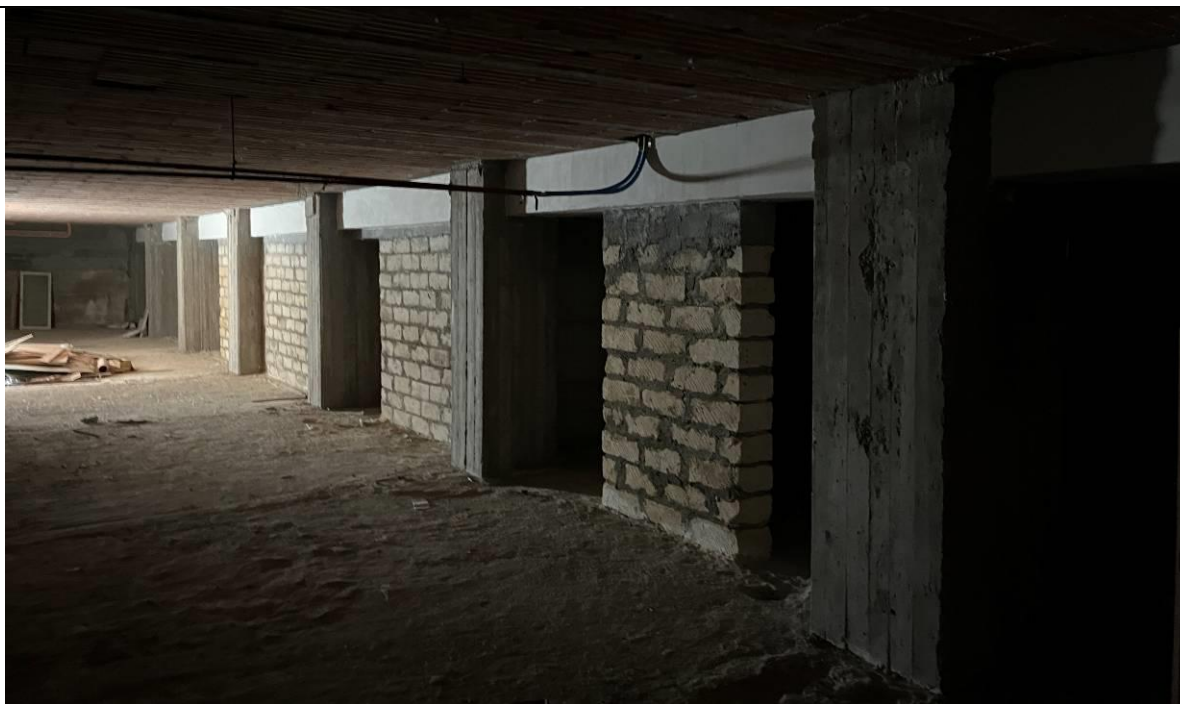
Foto 8 - La foto evidenzia in dettaglio l'attuale condizione dei vani al piano seminterrato dei Corpi A e B.
