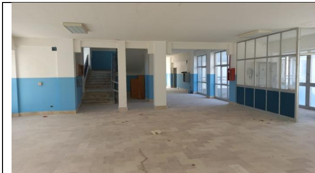
Foto 13 - Panoramica androne principale con vano scala I1.
