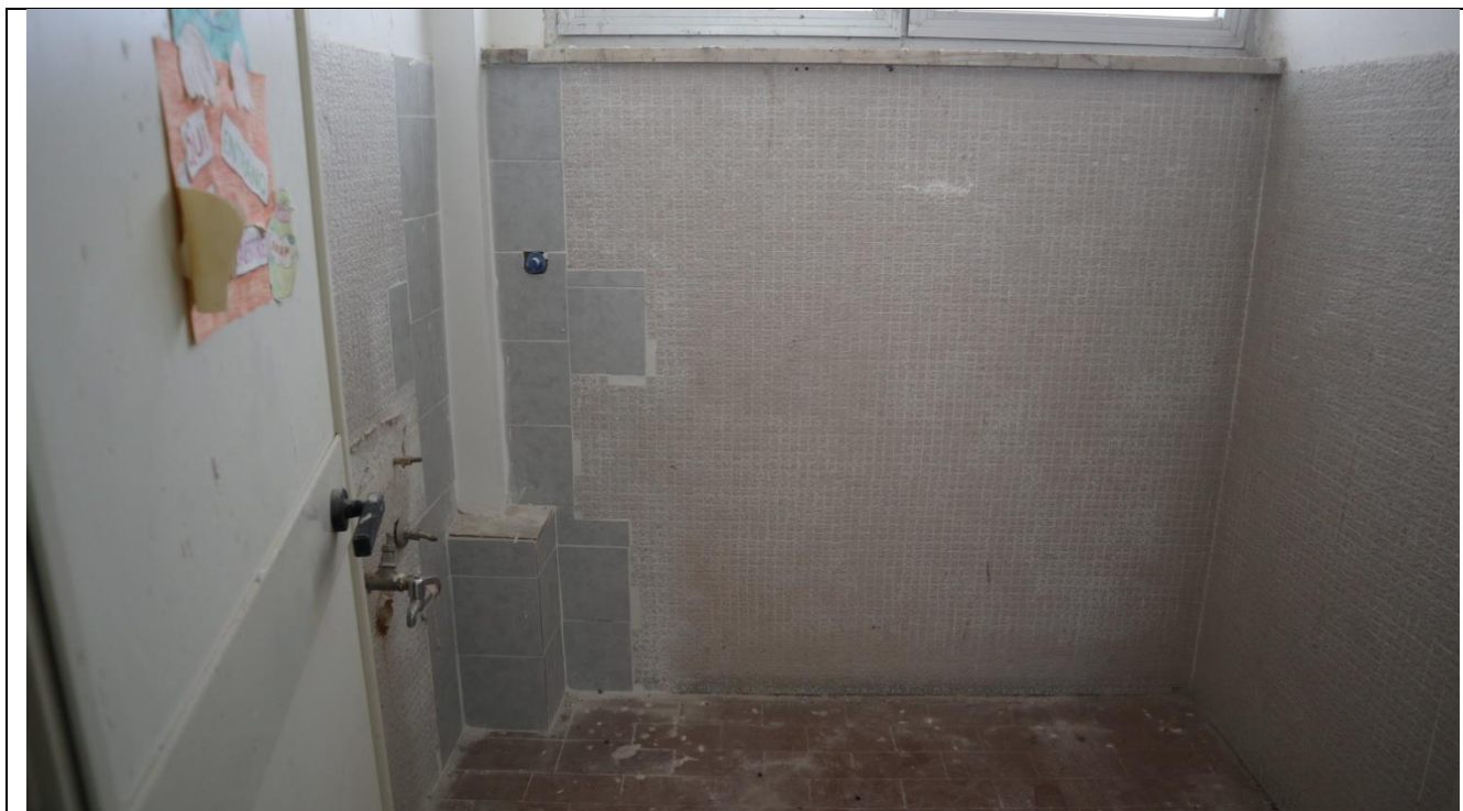
Foto 23 - Esempio condizioni attuali bagni corpo A piano primo
