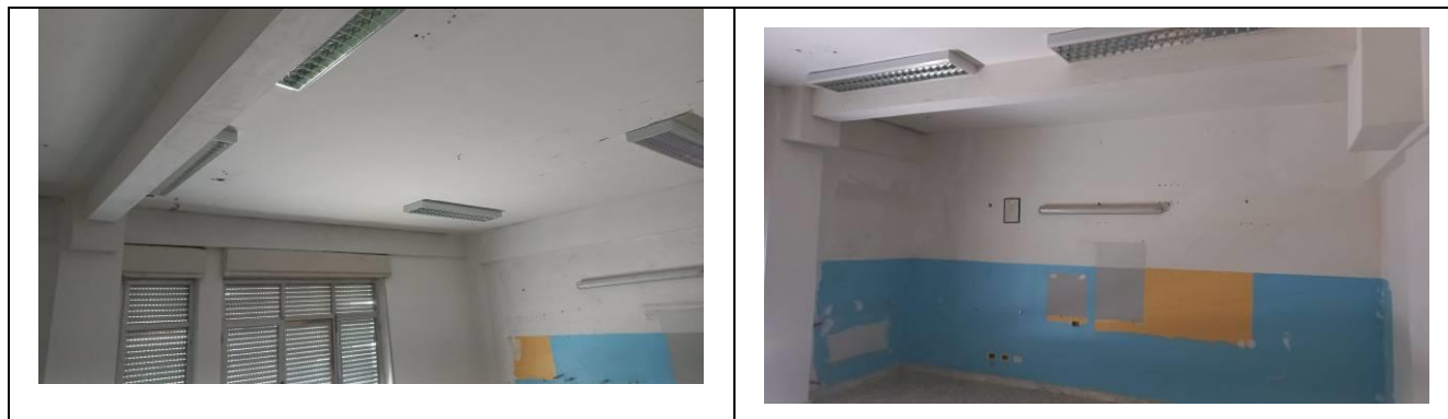
Foto 15 - Condizioni tipologiche di conservazione aule corpo A
