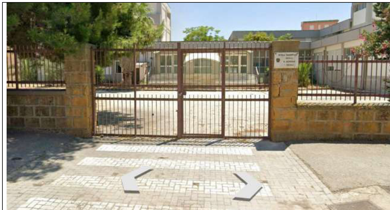
Foto 2 - Accesso carrabile e pedonale al n.c. 76 di via Rosolino Pilo
