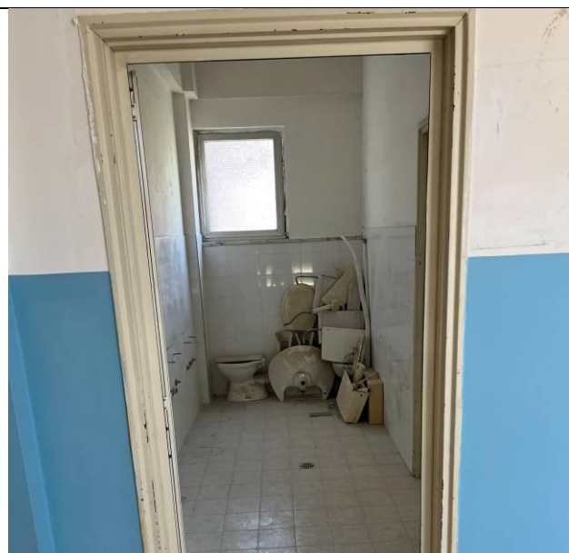
Foto 12 - Tipologia servizi igienici esistenti
