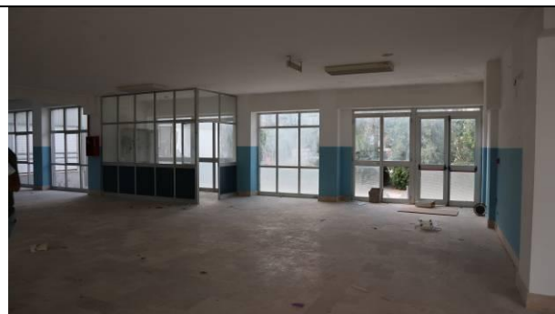
Foto 21 - panoramica androne piano rialzato
