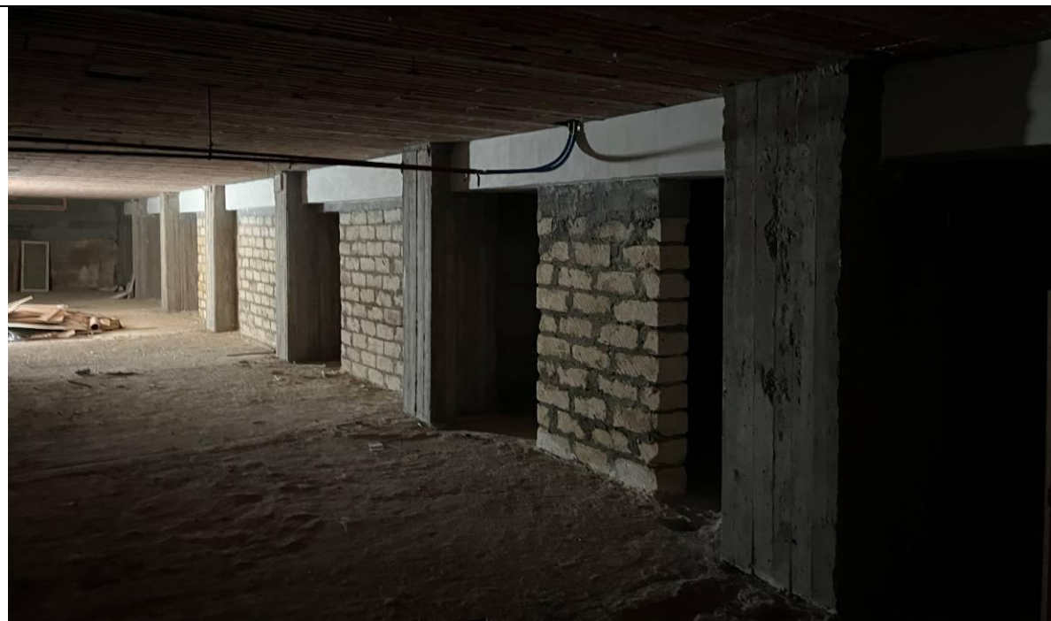
Foto 16 - Condizioni attuali dei Corpi A e B del piano seminterrato.
