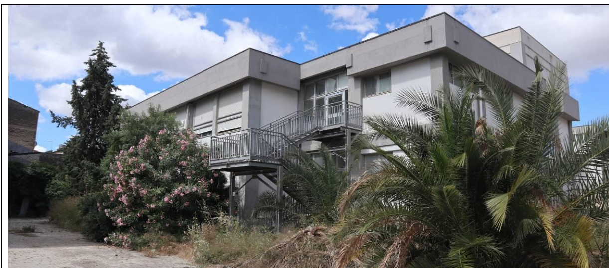
Foto 23 - vista scala di emergenza esterna
