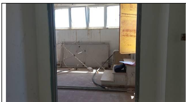
Foto 10 - Vano tecnico al piano secondo
