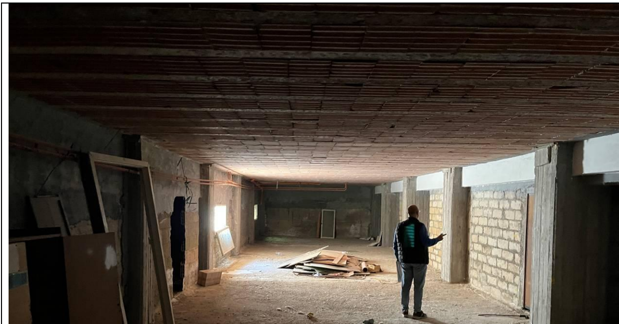
Foto 15 - La foto evidenzia il sistema dei telai in c.a. (pilastri e travi) e la tipologia di solaio in latero cemento
