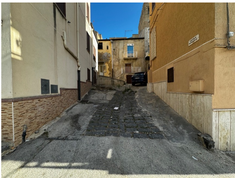
Figura 9 – Rilievo fotografico di via Trapani: vicolo Riposto
