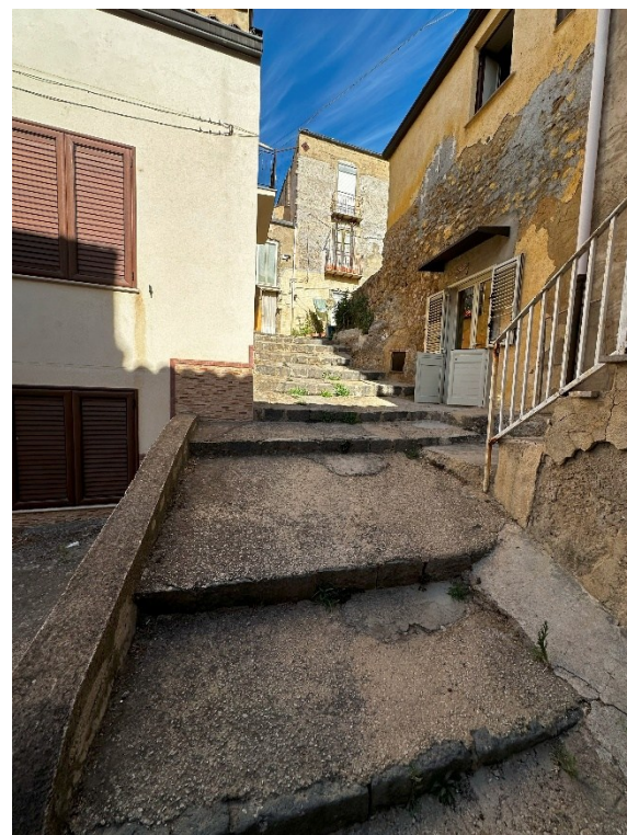
Foto 06 Scalinata Vicolo Riposto
