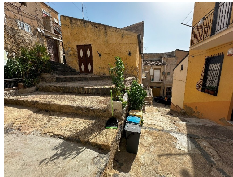
Foto 07 Scalinata vicolo Riposto
