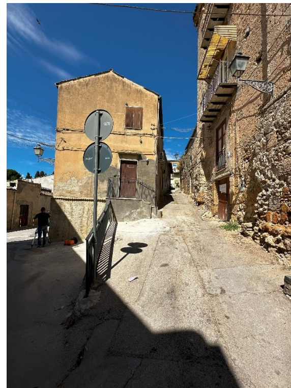
Foto 19 Rampa cortile C5
