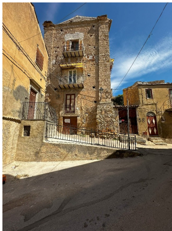
Foto 18 Rampa cortile C5
